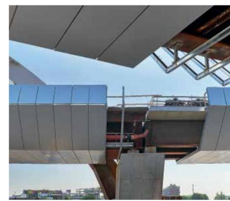
Pagina a fronte, in alto: la carteratura in carpenteria metallica del ponte ad arco sulla A4 e la pannellatura di rivestimento del viadotto Expo in fase di montaggio. In questa pagina: in alto, la pila a V e il pulvino in cemento armato a supporto del viadotto di
